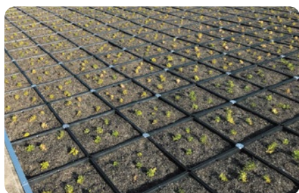
大阪府某工場 2020年 11月施工
