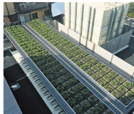
兵庫県マンション駐輪場 / 36.0 ㎡
