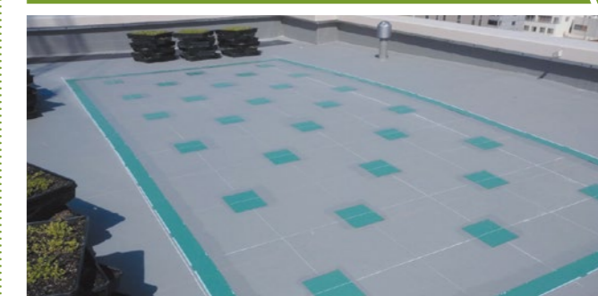
防水仕様によって防水保護シートを敷設します。
